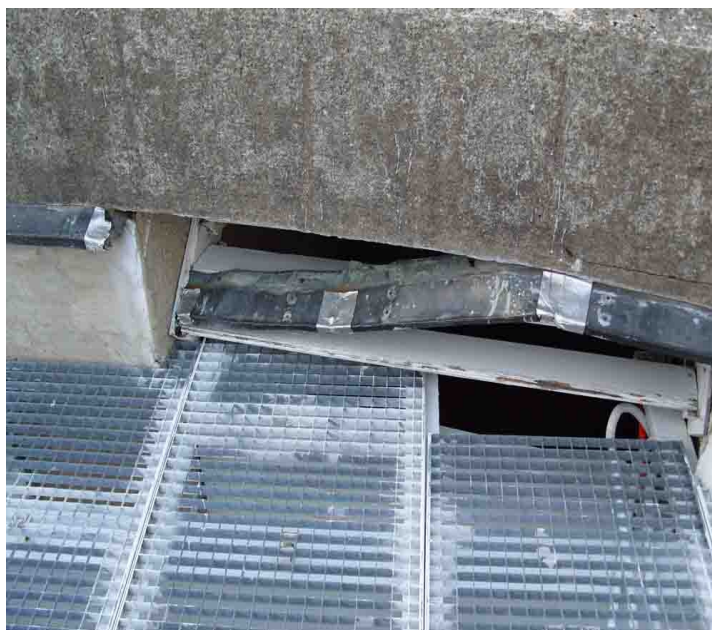
Renovierungsbedarf auf der Vereinssternwarte: Die Kuppeln benötigen einen neuen Anstrich, die Tropfkante muss repariert werden.
