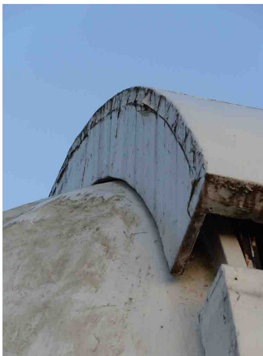
Renovierungsbedarf auf der Vereinssternwarte: Die Kuppeln benötigen einen neuen Anstrich, die Tropfkante muss repariert werden.
