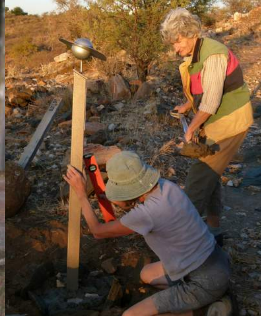
↑ Abb. 10: Elisabeth Straube und Uschi Pond betonieren die neue Saturnstele in den Boden ein; links im Bild liegt der alte Planetenpfosten mit dem ausgegrabenen Betonsockel
