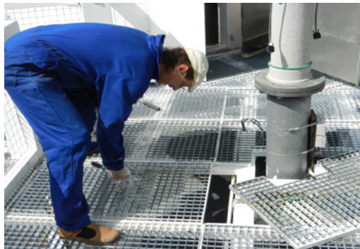
Ulrich Schüly beim Entfernen der Gitterroste
