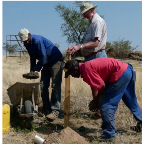
Abb. 5 – Die Holzpfosten mit den Planetenmodellen werden einbetoniert
